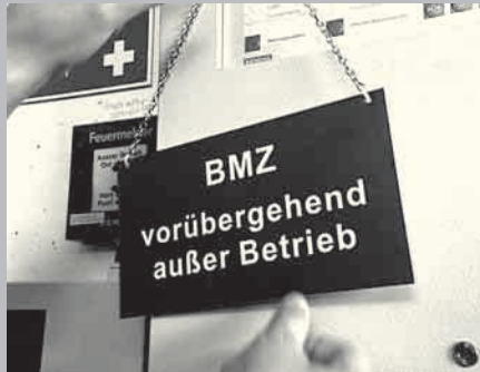
2 Vor dem Schweißen schaltet Dieter Bernius die Brandmeldezentrale (BMZ) ab.
